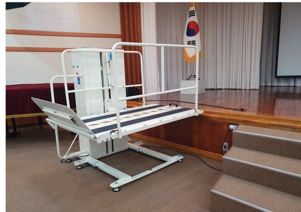
대강당 휠체어 리프트 설치
