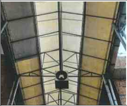
금사제일상가시장 cctv 설치
