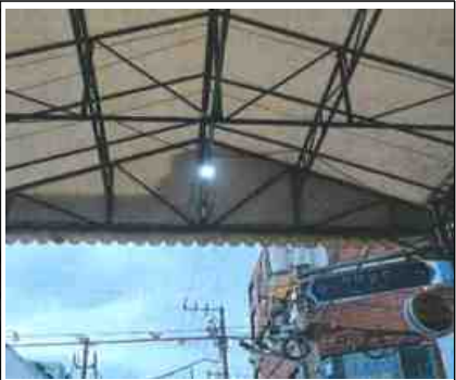
부곡시장 cctv 교체
