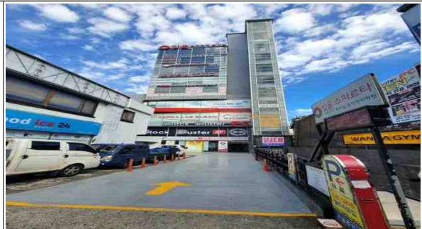
[근영테크빌 건물(지하2층/지상9층) 중 3층]
